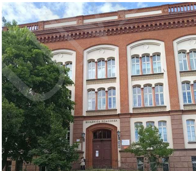
Fot. 1. Gmach Książnicy Pomorskiej w Szczecinie – budynek starszy. Archiwum własne autorek.
