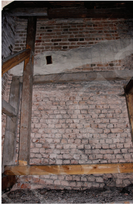
Ilustracja 8. Kościół farny we Wrześni – widok z poddasza obecnej zakrystii na zamurowane przezrocze empory, fot. M. Potocki (2009)
