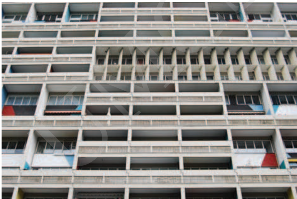
Ilustracja 11. Relief elewacji Jednostki Berlińskiej, fot. A. Pilip (2010).
